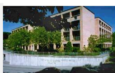
Residenza Gemmo (1989) Via Canevascini 30 - Besso
