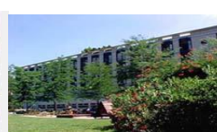
Residenza alla Meridiana (1991) Via Crocetta 8 - Viganello
